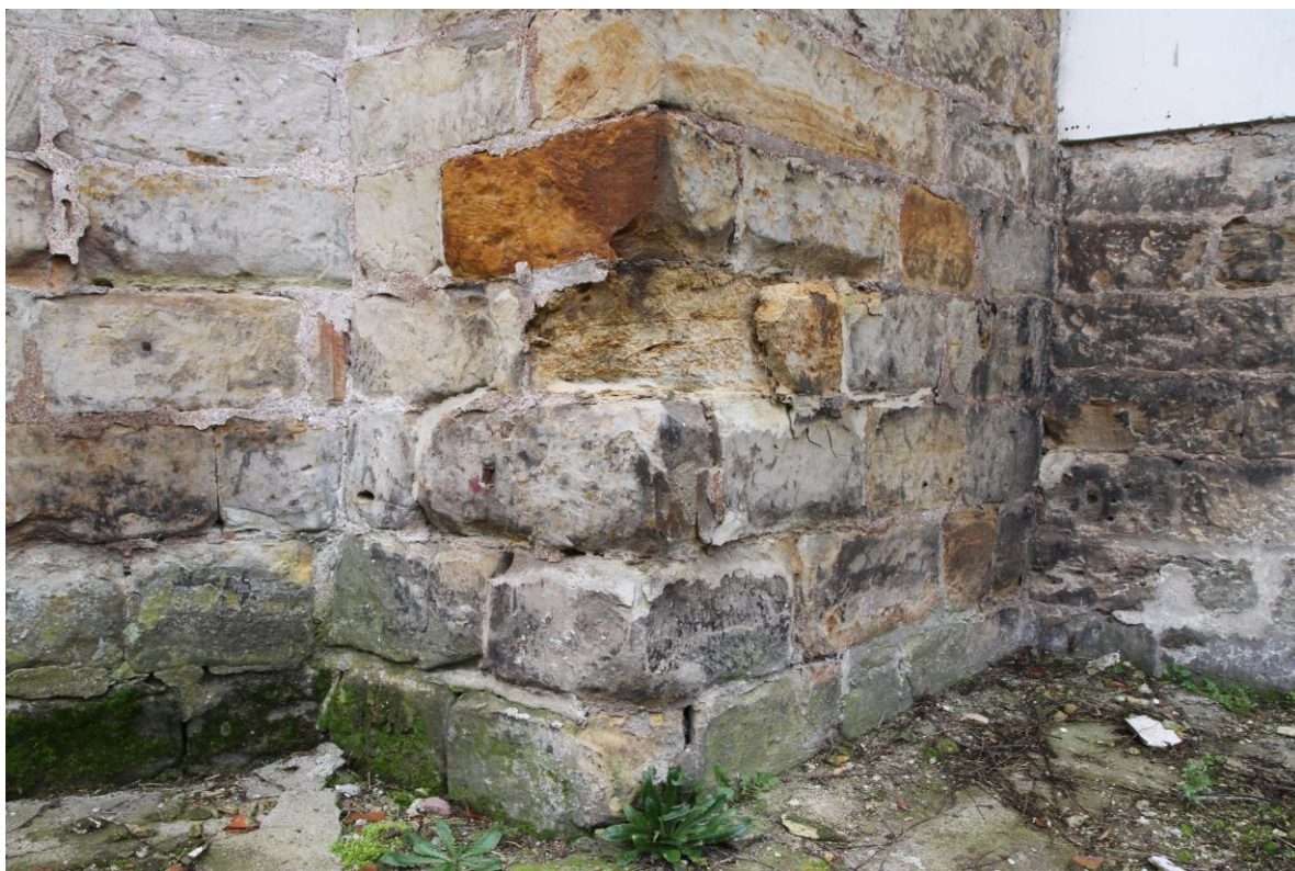
Detail degradace opěrného pilíře kaple
