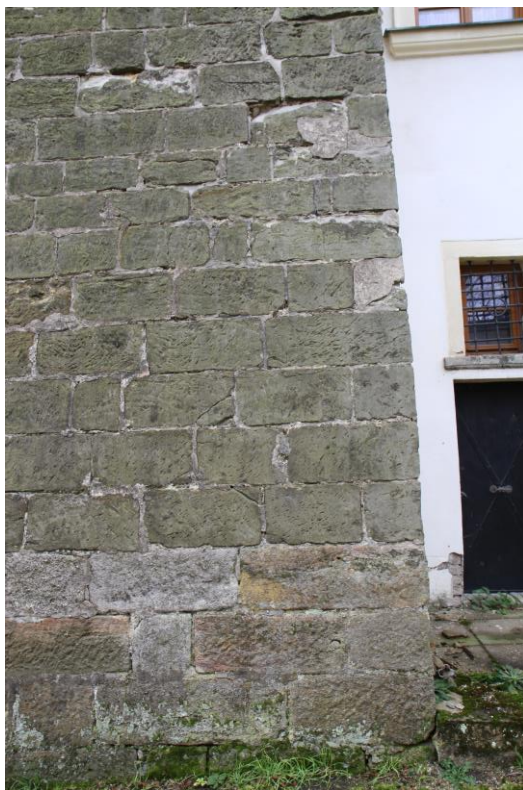
Pilíř č. 3-detail degradace zdiva
