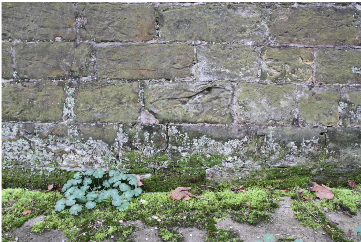
Pilíř č. 2-trhlina pilíře nad dlažbou
