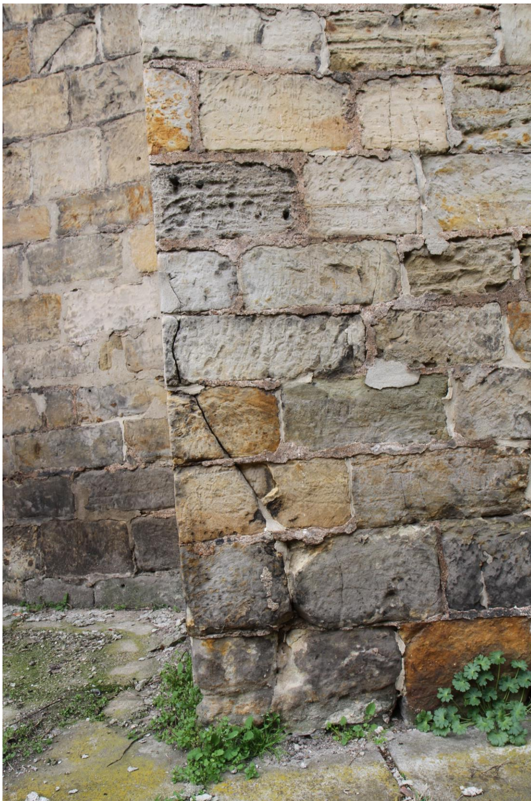
Detail trhlin a degradace kamene opěrného pilíře kaple
