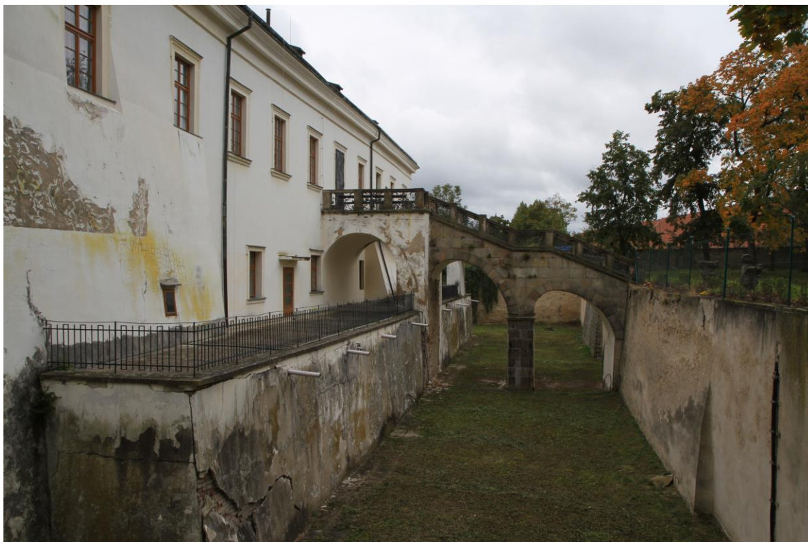
Silně poškozené omítky terasy na západním průčelí
