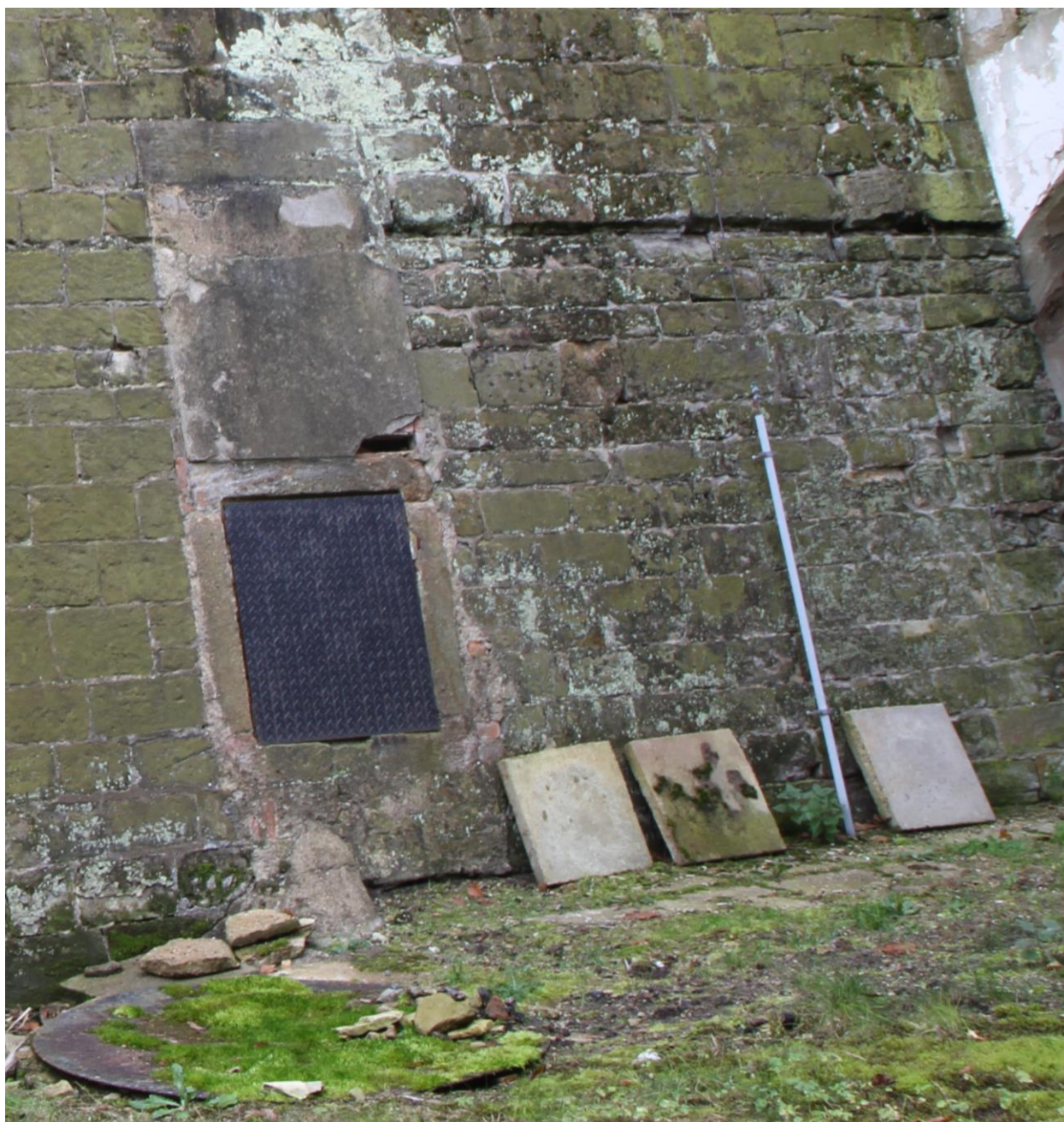
Ostění technických dvířek a zazděný otvor nad nimi
